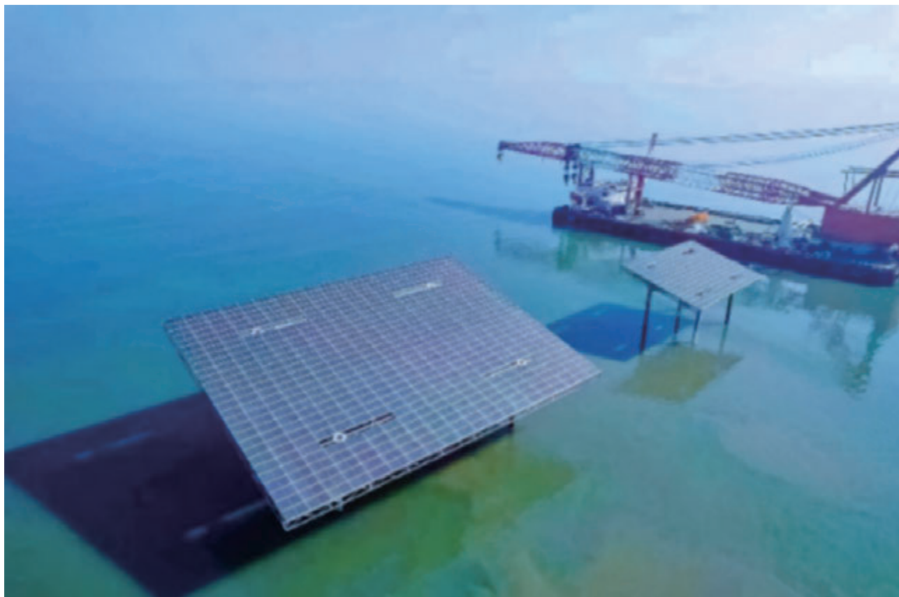
海阳HG34近海桩基式海上光伏实证项目现场图
