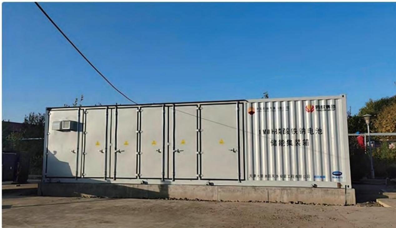
目前,大港油田在周边布置了 48 兆瓦的光伏发电设备,既有现实储能需求,也希望为“零碳厂区”建设提供技术支撑。截至目前,该试验电站累计充放电 180 余次,系统综合转换效率达 85.5%,整体运行平稳。1 月 2 日,中国电力科学研究院对该电站的电能质量及转换效率等 17 项关键指标进行检测,数据表明电站技术路线可行、充放电功能正常,满足运行要求。
