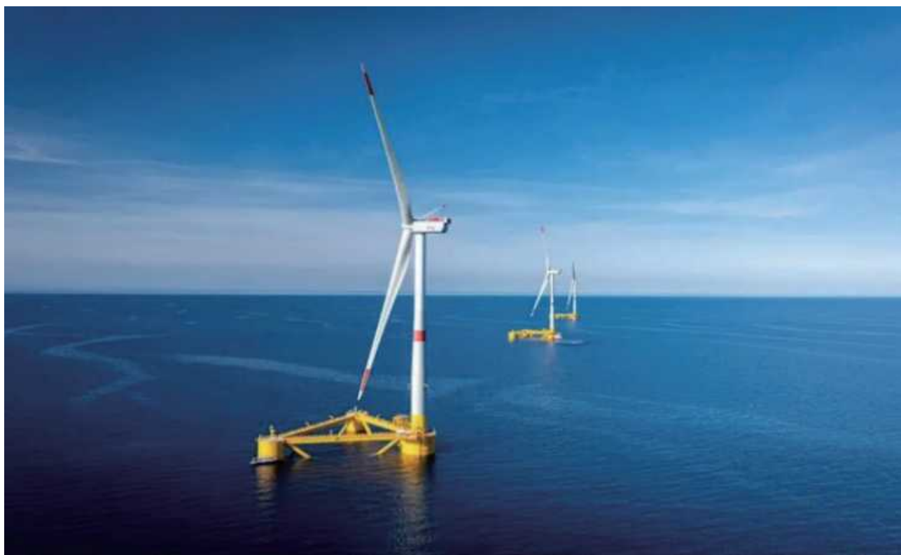
位于地中海的 Éoliennes Flottantes du Golfe du Lion 漂浮式海上风电场 © Ocean Winds/Occidrone
